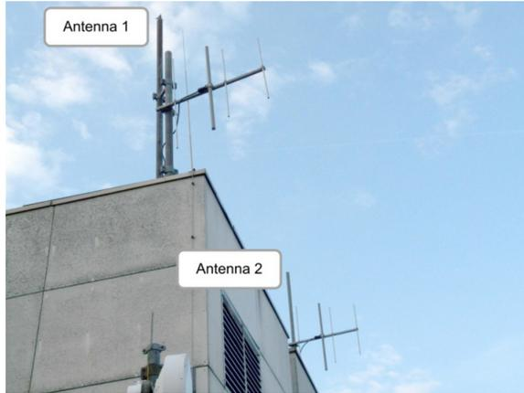
Fig. 7. Transmit antennas
